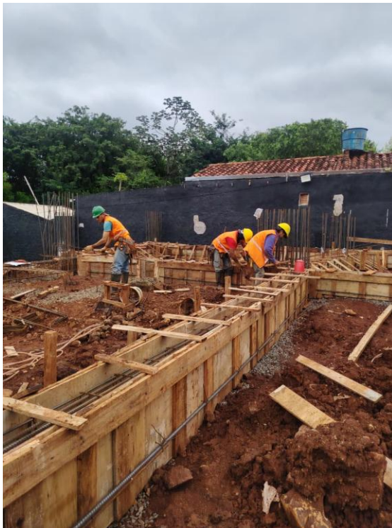
Armado, encofrado y hormigonado de vigas de fundación
