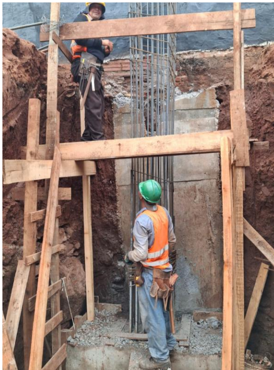
Armado, encofrado y hormigonado de fustes
